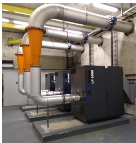
1.2.2.6 pav. Oro tiekimo sistemos modernizavimas – senosios orapūtės pakeistos moderniomis.
