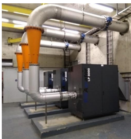
• 2018 m.- atliktas oro tiekimo sistemos modernizavimas, t. y. 20 metų senumo orapūtės pakeistos moderniomis su išmaniu orapūčių valdymo bloku (kilmės šalis - Vokietija). Projekto vertė – 337 000 Eur.
