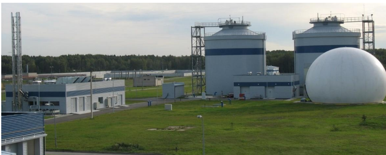
3 pav. Uždaro tipo dumblo pūdymo įrenginiai
