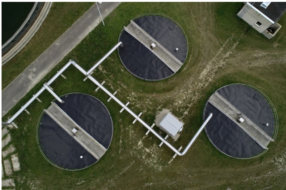
10 pav. Uždengti gravitaciniai tankintuvai
