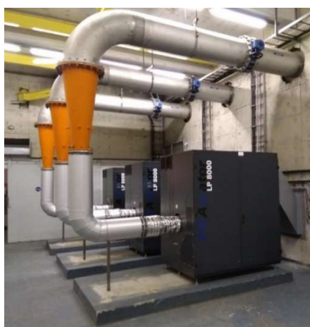
7 pav. Oro tiekimo sistemos modernizavimas – senosios orapūtės pakeistos moderniomis.
