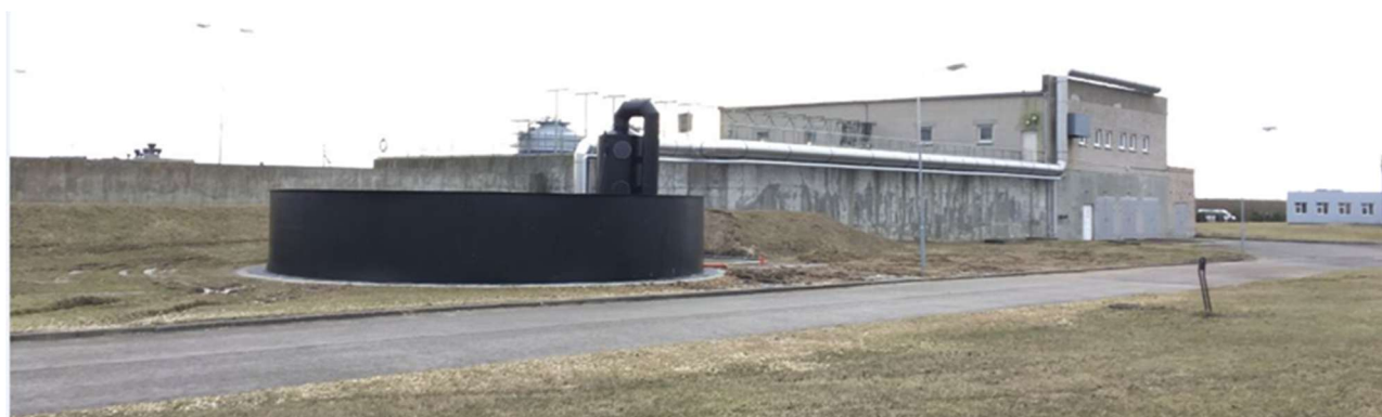
5 pav. Klaipėdos m. nuotekų valyklos pritekėjimo kameros oro valymo įrenginys (biologinis filtras).
